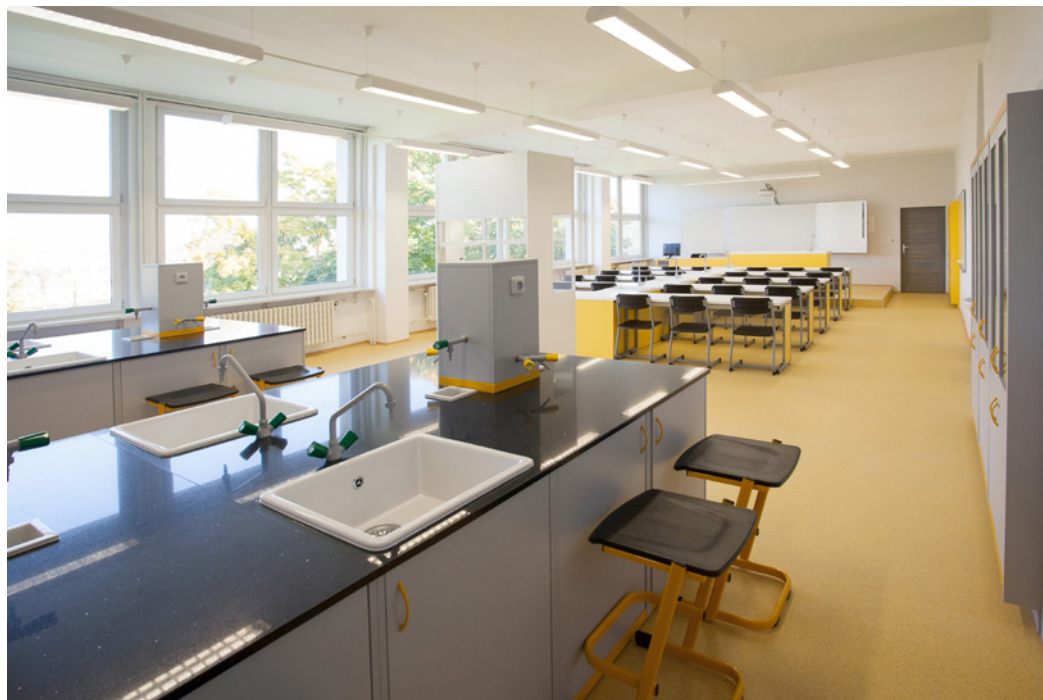
Laboratorní stoly s deskou Technistone a laboratorními komínky
